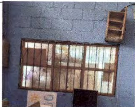
Foto 3: MANTENIMIENTO DE BALCONES DE METAL
