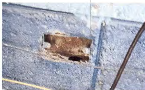
Foto 8: SUSTITUCIÓN DE TOMA CORRIENTES DOBLES
