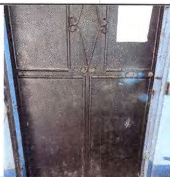
Foto 10: SUSTITUCION DE PUERTA
