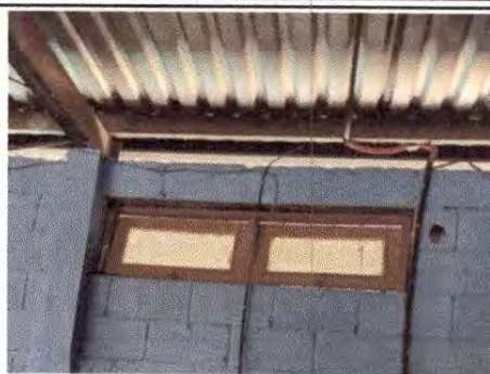
Foto 2: SUSTITUCIÓN DE VENTANA DE MADERA POR METAL MAS VIDRIO.
