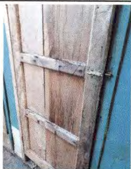
Foto 1: SUSTITUCION DE PUERTA DE SERVICIO SANITARIO
