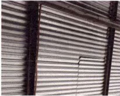
Foto 13: SUSTITUCIÓN DE LAMINA, POR LAMINA TROQUELADA ALUZINC CALIBRE 26
