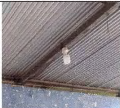
Foto 7 : SUSTITUCIÓN DE FOCOS AHORRADORES
