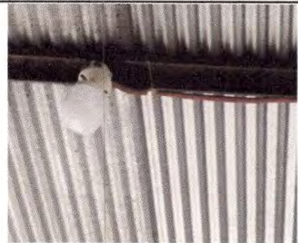
Foto 14: SUSTITUCIÓN DE FOCOS AHORRADORES
