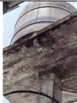
Foto 16: SUSTITUCION DE DEPOSITO DE AGUA DE 1700 LITROS-
